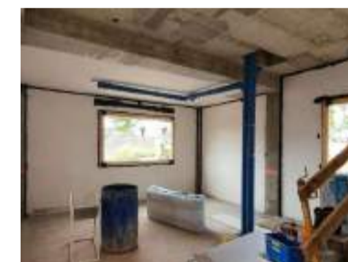
Detalle de solución de la hermeticidad en huecos de fachada con el premarco, con pintura Soudatight LQ.
