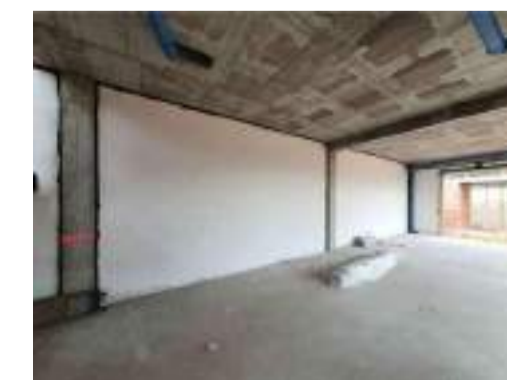
Detalle de solución de la hermeticidad en muros y pilares con pintura Soudatight LQ.
