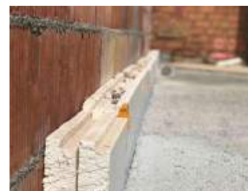
Detalle de aislamiento térmico entre solera exterior y el cerramiento de la vivienda.
