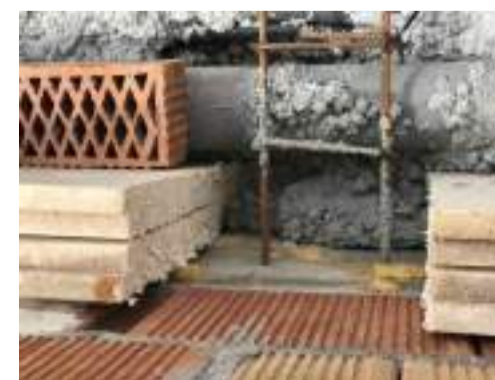
Detalle del encuentro entre solera exterior y la estructura principal de la vivienda, permitiendo el paso del aislamiento.
