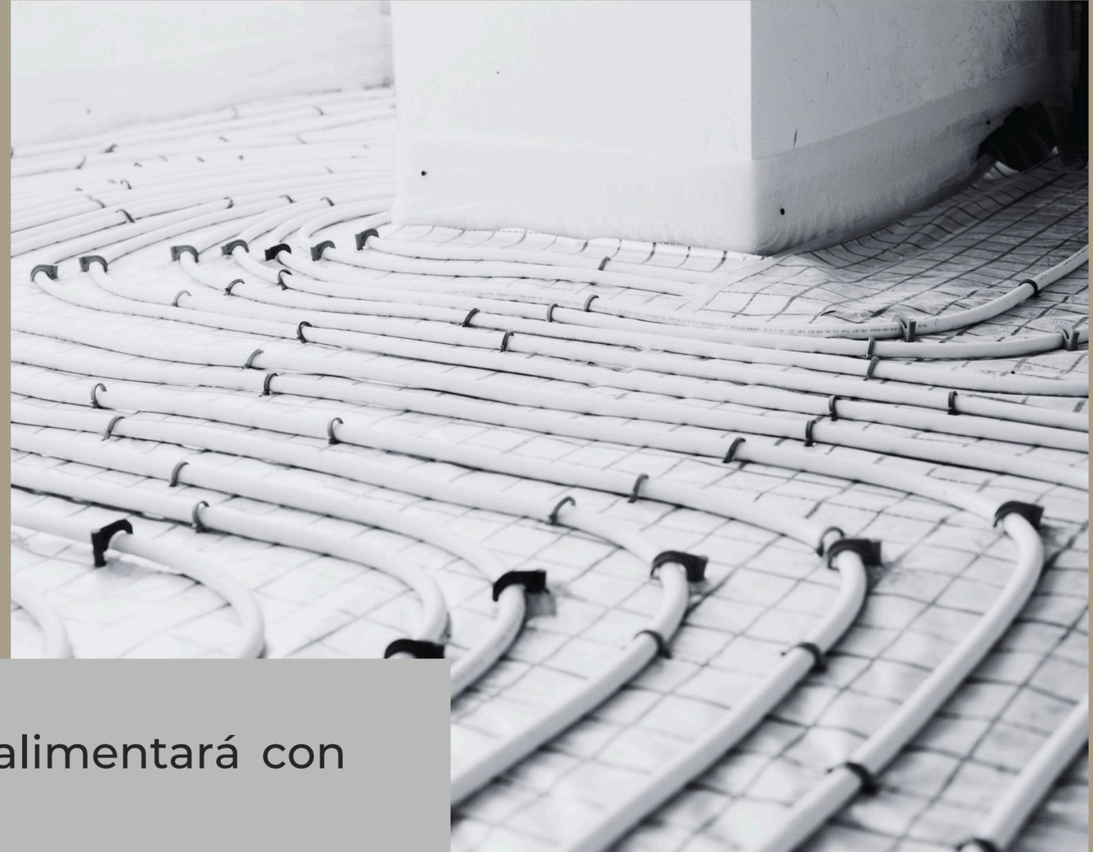
·Se colocará suelo radiante, este sistema se alimentará con un equipo aerotérmico (frío y calor).
