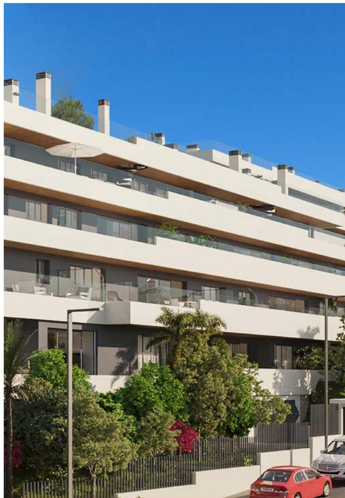
Las fachadas exteriores en prefabricado de hormigón blanco y en su cerramiento propiamente dicho con fábrica de 1/2 pie de ladrillo, aislamiento termorreflexivo, y trasdosado de placa de pladur sobre estructura auxiliar metálica. Las zonas entre ventanas y ventanales se forrarán con panel composite del mismo color que el aluminio de ventanas.
