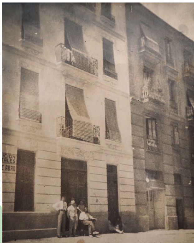
Fotografía de la fachada original
